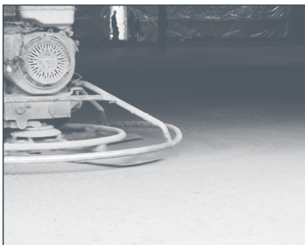
Figure 6-3 Finition du béton fibré
