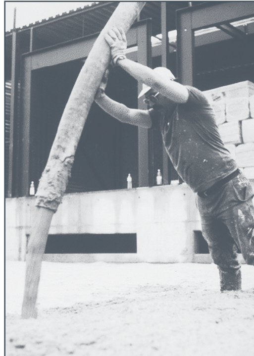
Figure 6-1 Pompage du béton
