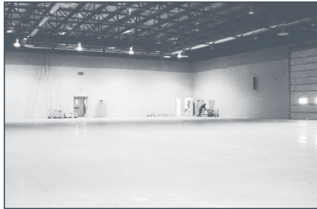
Figure 8-1 Dalles sans joints de contrôle
