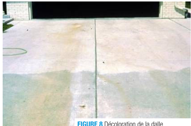
FIGURE 8 Décoloration de la dalle
