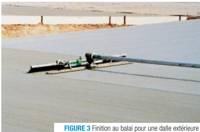
**FIGURE 3** Finition au balai pour une dalle extérieure
