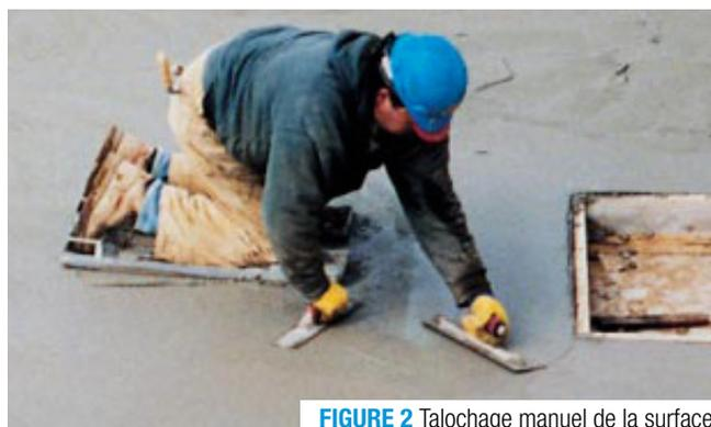
FIGURE 2 Talochage manuel de la surface
