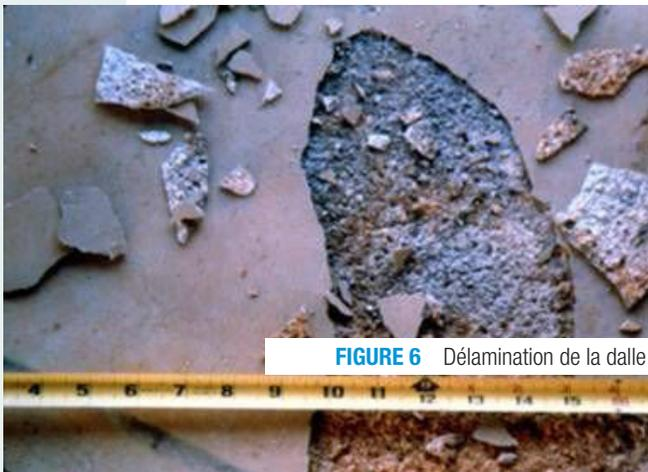
FIGURE 6 Délamination de la dalle
