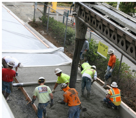
FIGURE 7 Mise en place du béton drainant
