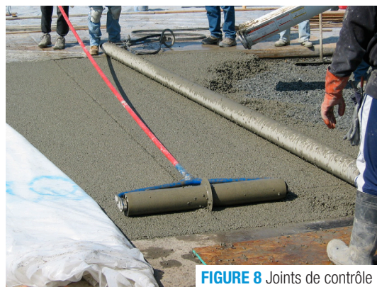
FIGURE 7 Mise en place du béton drainant
