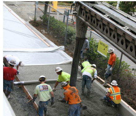
FIGURE 7 Mise en place du béton drainant
