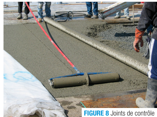
FIGURE 7 Mise en place du béton drainant
