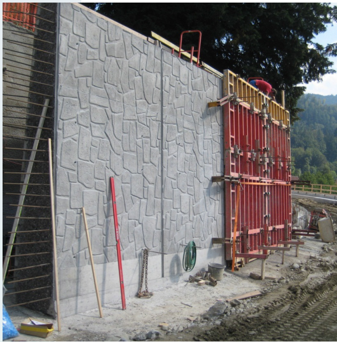
FIGURE 6 Parement réalisé avec matrices de coffrage (5)
