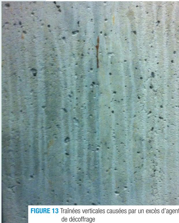
**FIGURE 13** Traînées verticales causées par un excès d'agent de décoffrage
