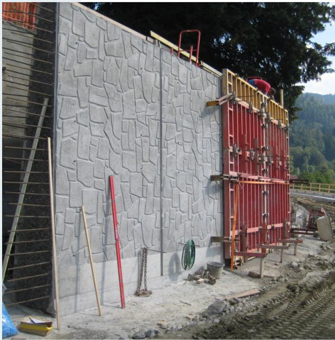
FIGURE 6 Parement réalisé avec matrices de coffrage<sup>(5)</sup>
