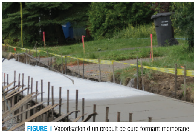
FIGURE 1 Vaporisation d'un produit de cure formant membrane
