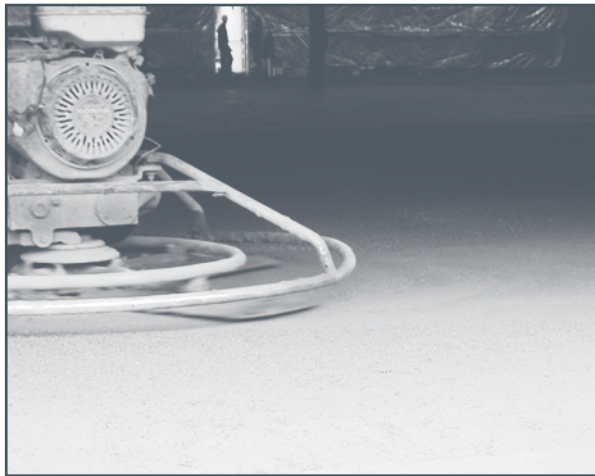
Figure 6-3 Finition du béton fibré
