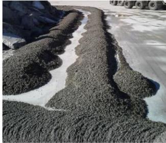
Fabrication d'andains pour granulats recyclés
